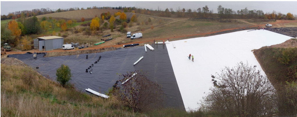
Pokládka těsnící vrstvy při realizaci V. etapy skládky Kuchyňky.
