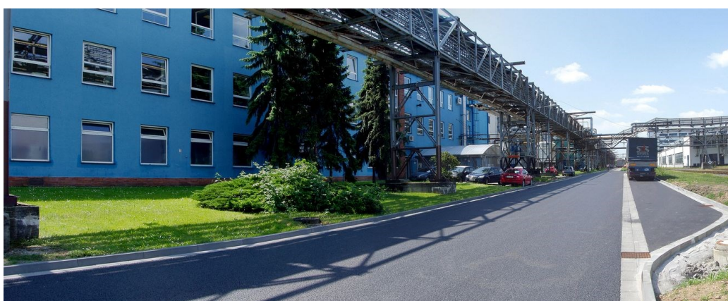
Nová komunikace ve Výrobním a logistickém areálu Chropyně
