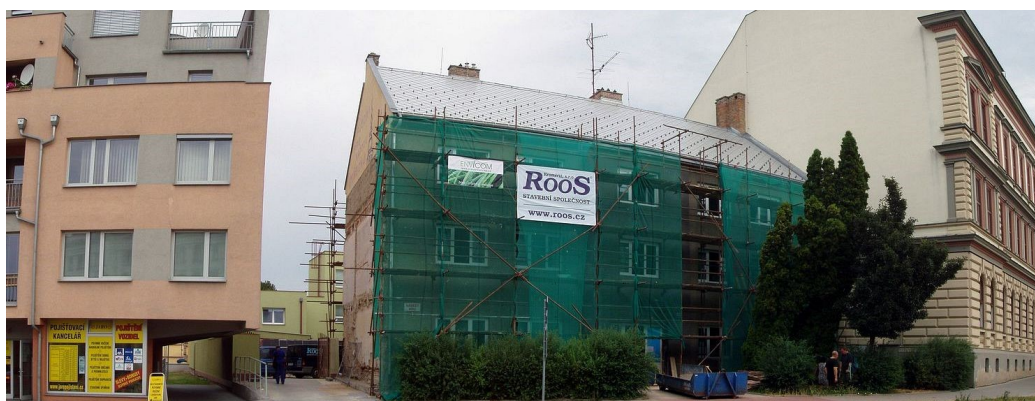
Rekonstrukce fasády bytového domu ÚHÚL Kroměříž
